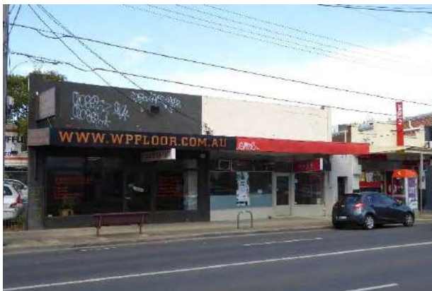
Nos 730-734 Heidelberg Road
