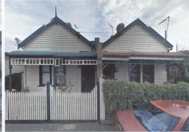
....no. 26 & 24 canterbury street..
