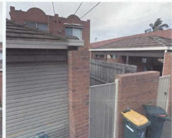
....no. 17 & 19 canterbury street..
