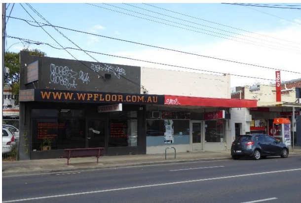
Nos 730-734 Heidelberg Road
