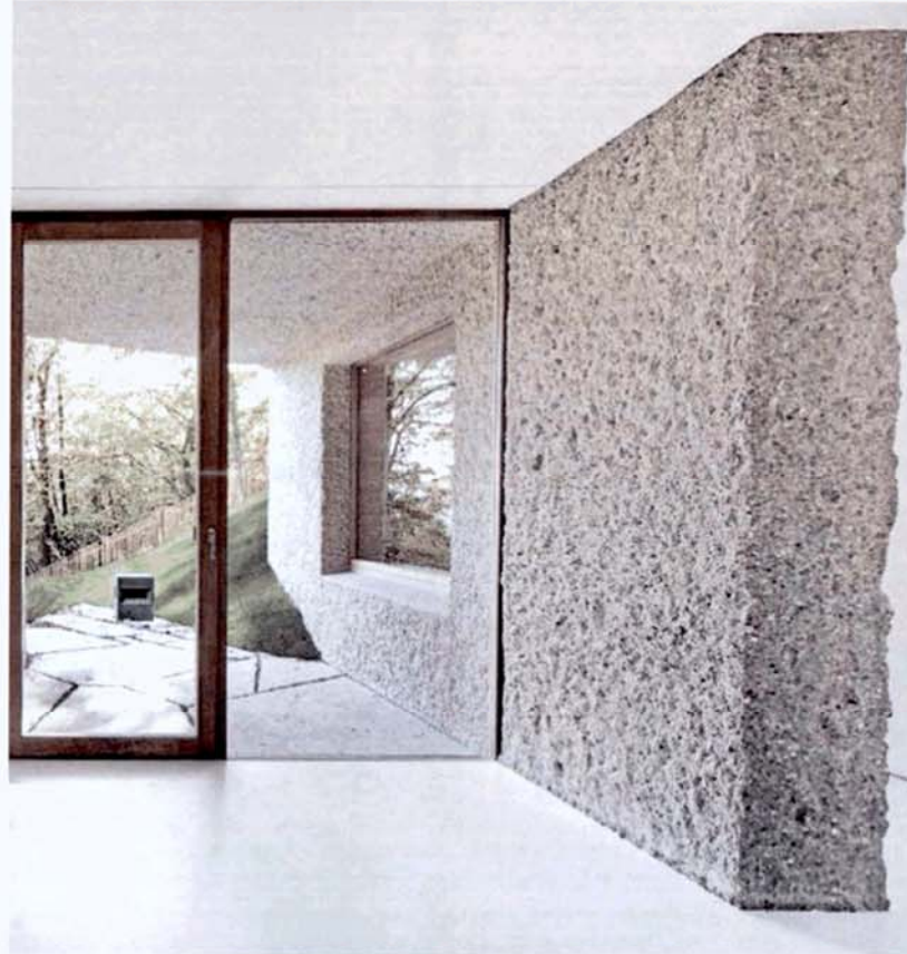
BUSH HAMMERED CONCRETE WALL - Unterlandstättner Architekten
