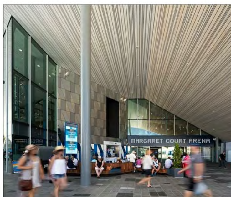
CD-05 METAL BATTENS - SOFFIT
